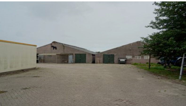
Rechter schuur wordt gesloopt, linker schuur blijft behouden
