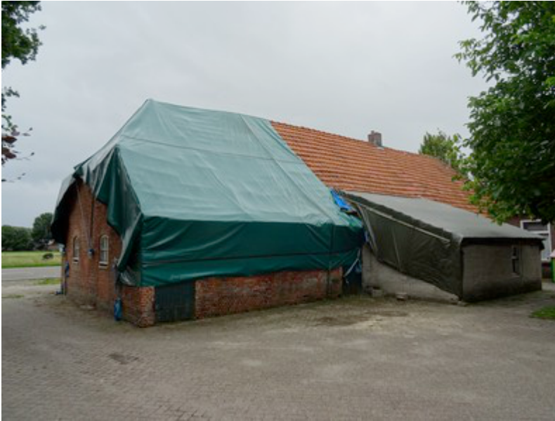
Te slopen bedrijfswoning
