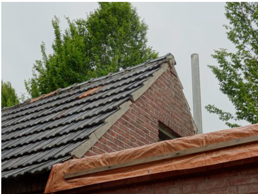
Afbeelding 4: Gescheurde betonvoegen als geschikte openingen voor vleermuizen. Foto: K. van Veen | Ecoresult B.V.
