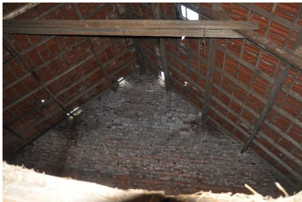
Afb. 56. De gording dragende brandgevel.
