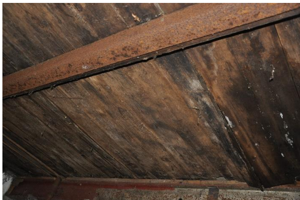
Afb. 53. De varkensstal houten plafond op stalen en houten balken.
