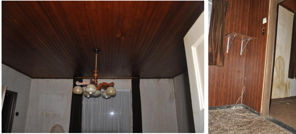
Afb. 32 en 33. het paranapine schrootjes plafond en de betimmering van de slaapkamer.
