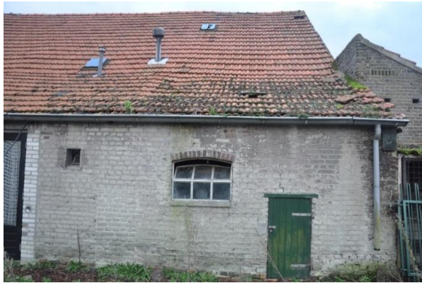
Afb. 17. Achtergevel geheel rechts.
