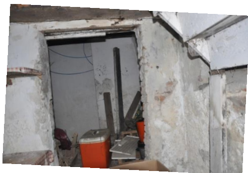
Afb. 50. De doorgang naar de aangrenzende kelder.
