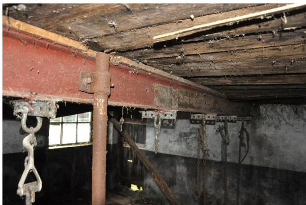
Afb. 54. De aanbouw koeienstal met stalen zolderondersteuning waaraan tevens de bevestiging van de kettingen waarmee de koeien werden vastgezet.
