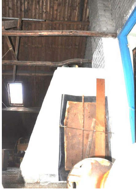
Afb. 30. Het rookkanaal met rookluik.
