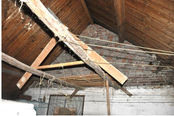
Afb. 55. De gording dragende brandgevel
