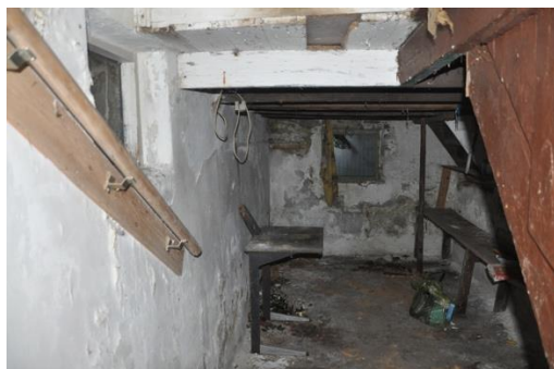
Afb. 48 en 49. Foto links de kelder, rechts de trap(boom) naar de opkamer. Foto kelder met aan de rechterzijde een tweede trapje naar de opkamer. (In de opkamer tekent zich hier een restant van een deur af.)
