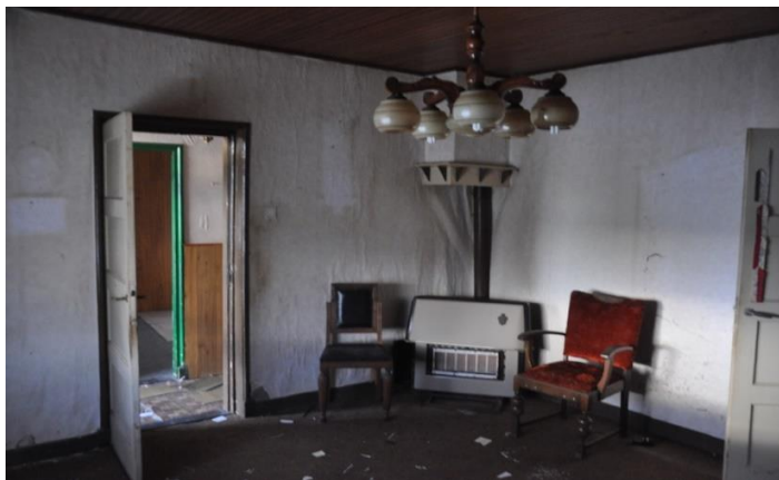
Afb. 31, Het schouwte met rookgasafvoer
