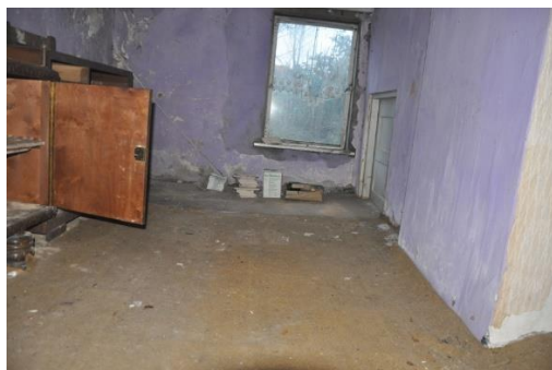
Afb. 51. De opkamer met geheel achter aan de linkerzijde het restant van een deur welke ooit toegang gaf tot deze opkamer.
