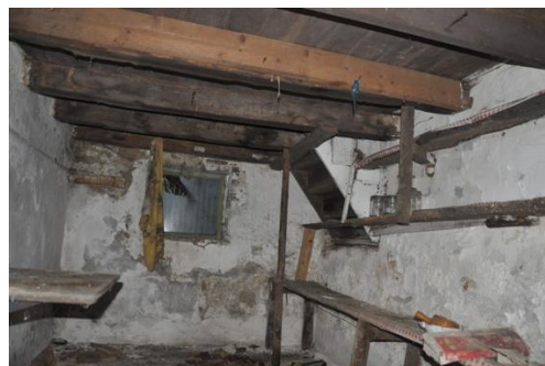
Afb. 48 en 49. Foto links de kelder, rechts de trap(boom) naar de opkamer. Foto kelder met aan de rechterzijde een tweede trapje naar de opkamer. (In de opkamer tekent zich hier een restant van een deur af.)
