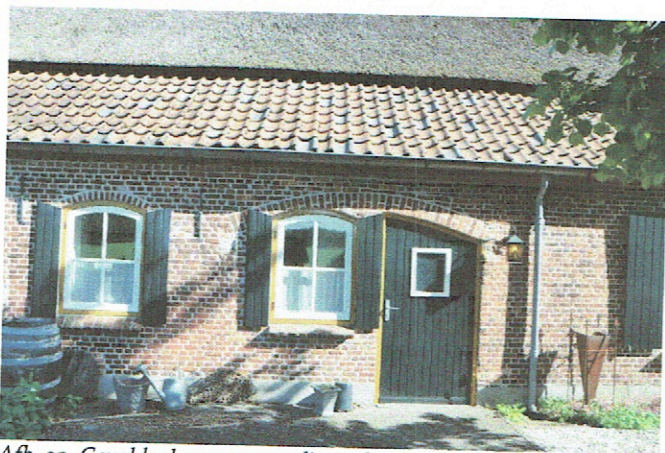
Afb. 23. Geveldeel van voormalig stalgedeelte.
