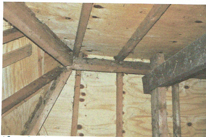
Afb. 34. Spantbeenen, hoekkepers, nok, daksoren en underlayment platen boven bedrijfsgedeelte.
