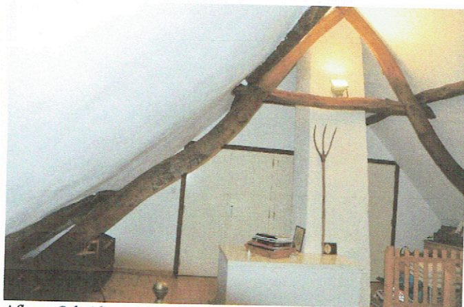
Afb. 31. Scheidingswand waarachter o.a. verwarmingsinstallatie.
