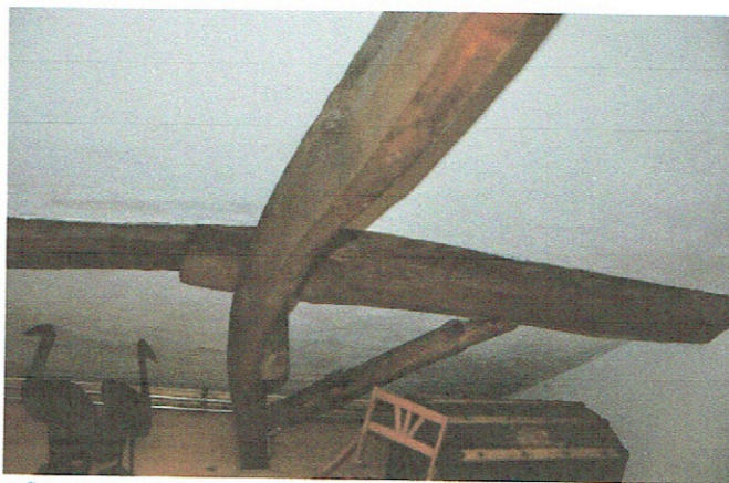
Afb. 33. Spantbeenen, gording en schoor windverband.
