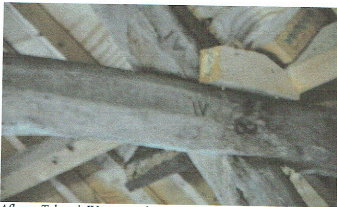
Afb. 32. Telmerk IV op spantbeen en trekplaat.
