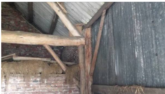
Gebintconstructie met ankerbalkgebint en hierop geplaatste A-spant.
