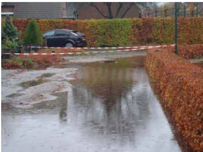
Foto 1 Geopende putdeksel vuilwaterriool, 14/11/2010, 12:27:00
