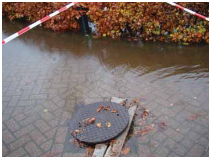
Foto 2 Geopende putdeksel vuilwaterriool, 14/11/2010, 12:27:00
