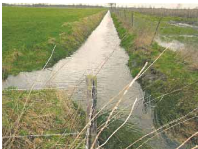
Foto 15 Hoogte oude dam onvoldoende. Afvoer naar de Breerijt (februari 2002)
