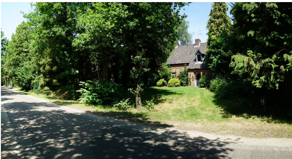
Het perceel Stökskesweg 42 heeft veel bomen langs de perceelsranden. De woning ligt duidelijk hoger dan de weg.
