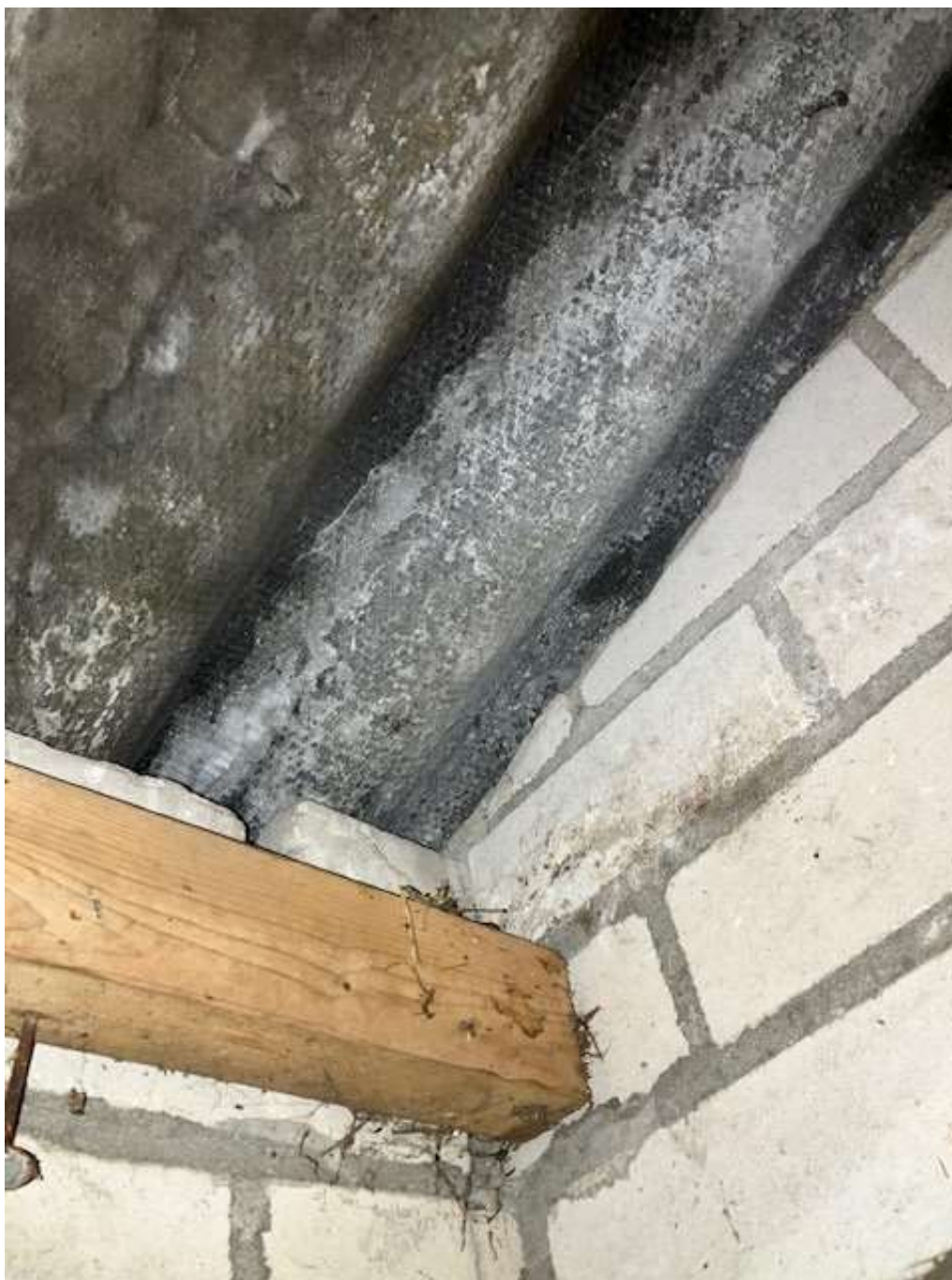
• Afbeelding 11: foto dak binnenzijde.
