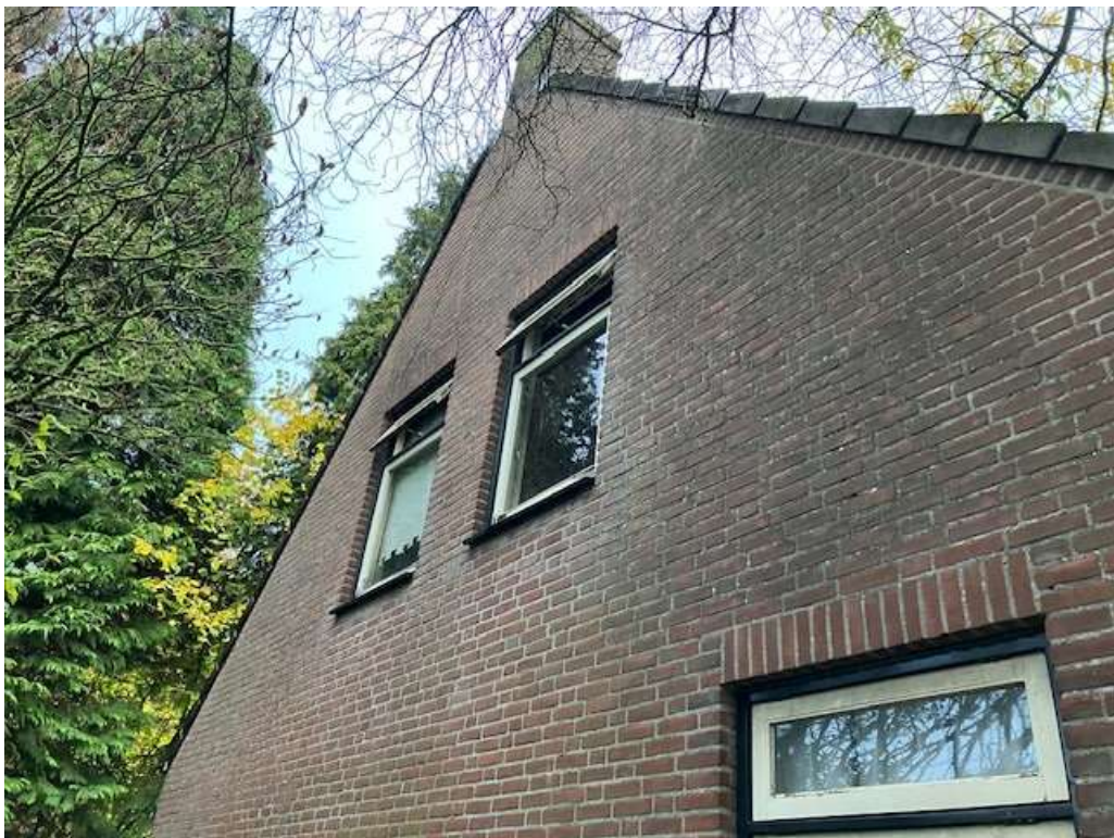
• Afbeelding 23: Kopgevel Stökskesweg 42, kantpannen strak tegen het metselwerk, geen kieren/naden, geen vetsporen
