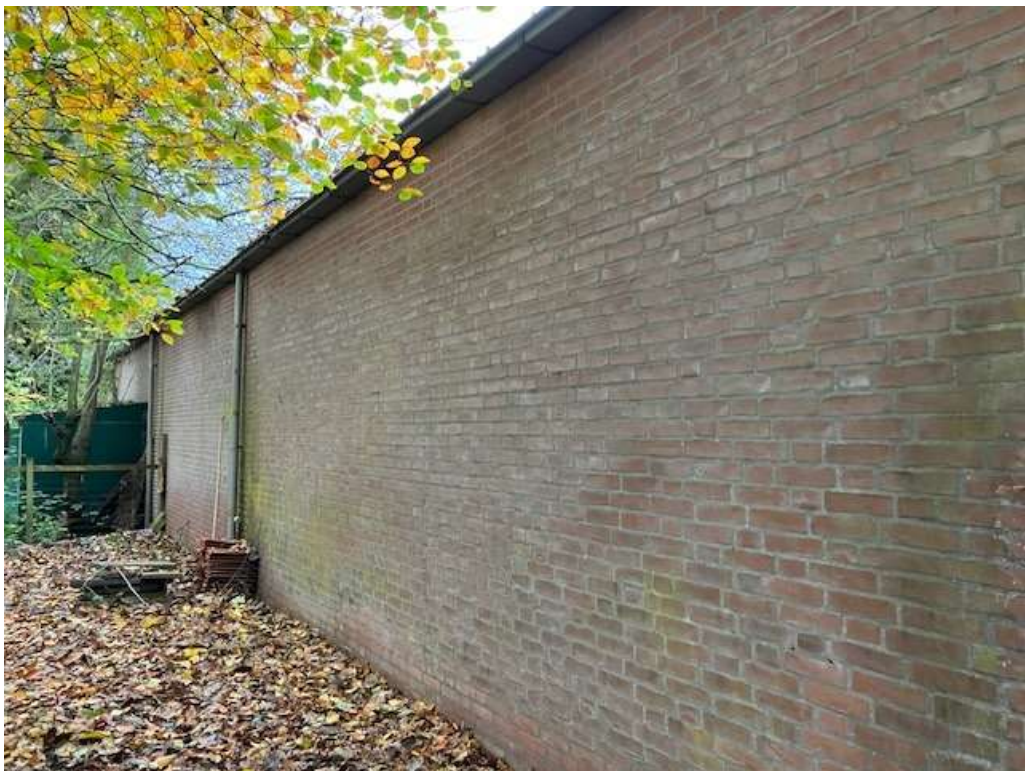
• Afbeelding 13: Achterzijde schuur, geen scheuren in de gevel geen open stootvoegen en dakgoot strak tegen de gevel
