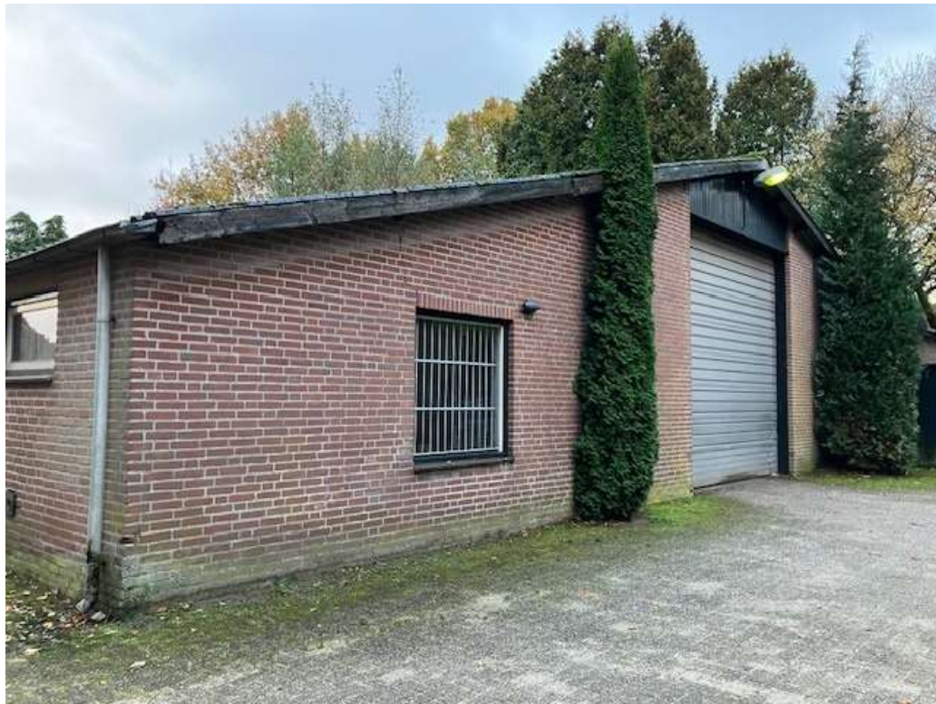
• Afbeelding 4: Te slopen schuur
