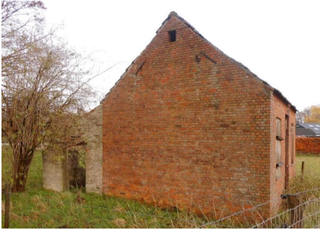
Afb. 13. Foto westgevel met aanbouw.
