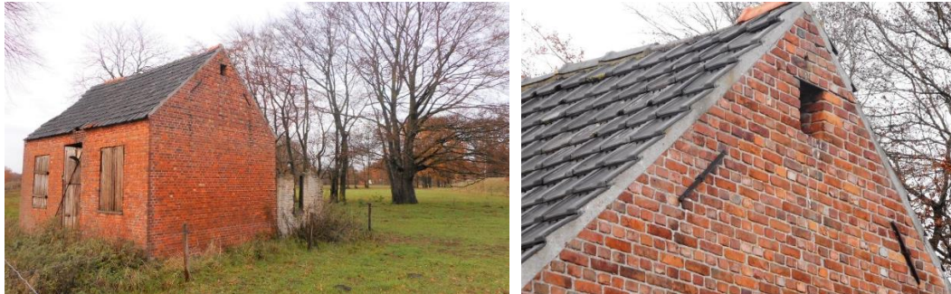
Afb. 17. en 18. Foto oostgevel en detail gevelopening t.b.v. een uil.
