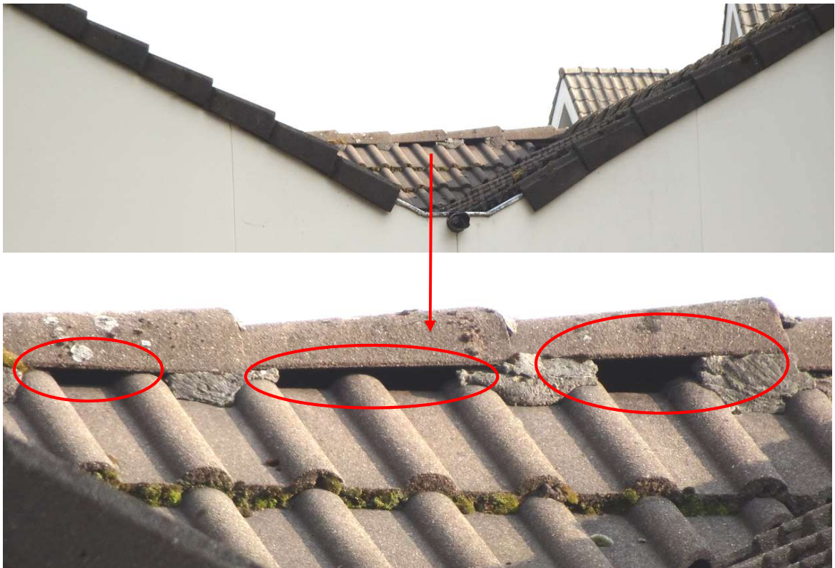
Vervolg figuur 3. Potentiële verblijfplaatsen van vleermuizen aan de Burgemeester Magneestraat 57 te Bergeijk.
