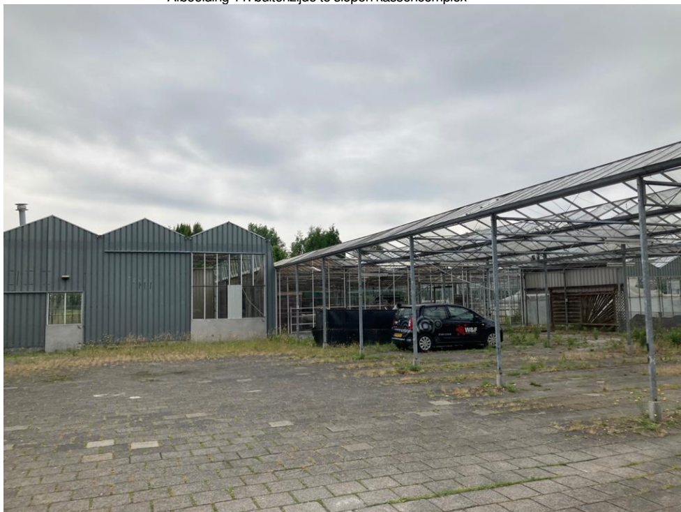
• Afbeelding 11: buitenzijde te slopen kassencomplex
