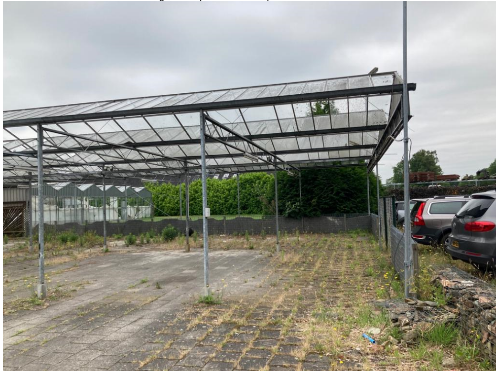
• Afbeelding 3: te slopen kassencomplex
