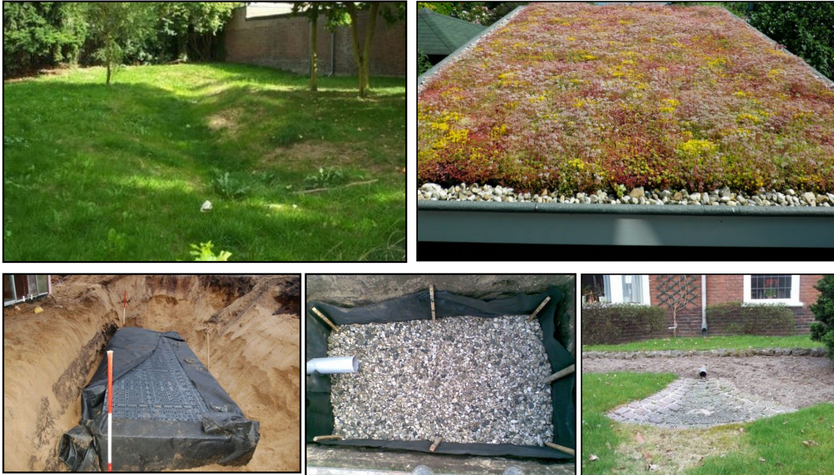
Figuur 13: Voorbeelden infiltratievoorzieningen
