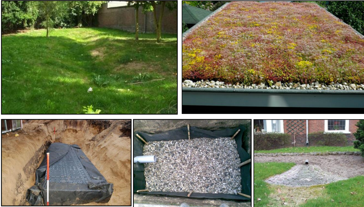
Figuur 13: Voorbeelden infiltratievoorzieningen
