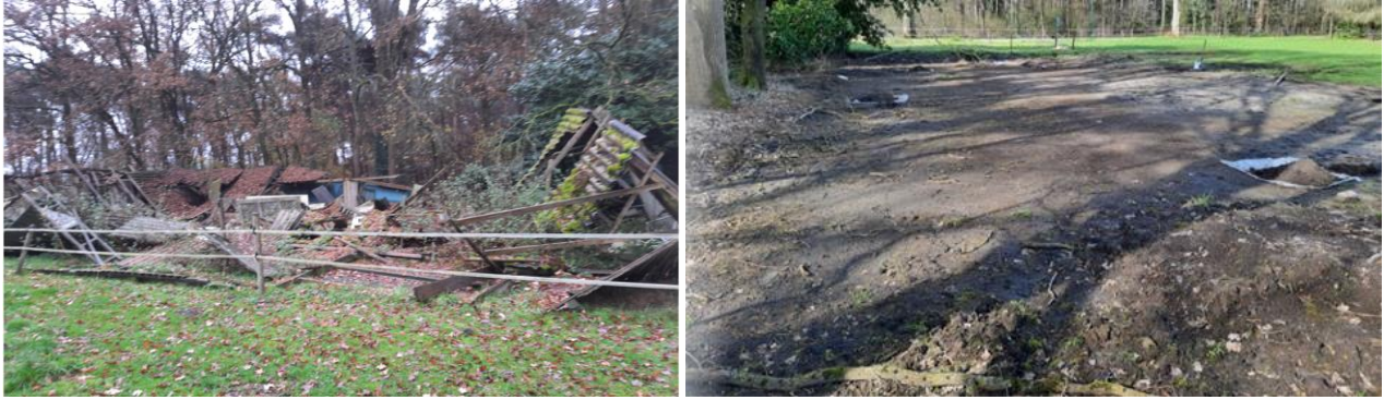
Afbeelding 1: Foto vervallen schuur d.d. 16-11-21 en foto genomen tijdens het veldwerk op 11-4-2022, zie ook bijlage 2
