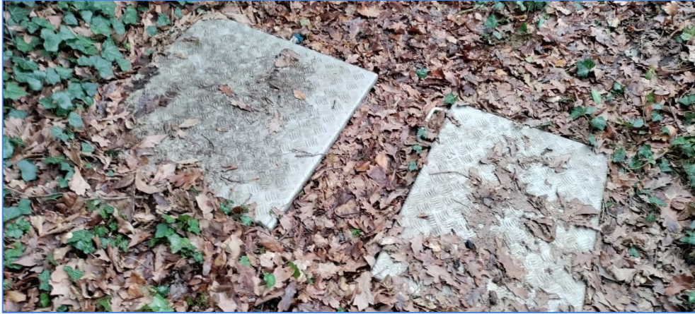
Afbeelding 3 Aluminium luiken put rioolgemaal (bestaande situatie)
