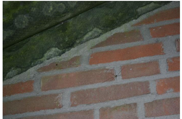
Figuur 4.4.1. In de achtergevel (linkerfoto) van de lange schuur (2 in figuur 4.1.1) zijn kieren aanwezig waar vleermuizen door de spouw in kunnen. In de voorgevel (rechterfoto) zijn kieren afwezig.
