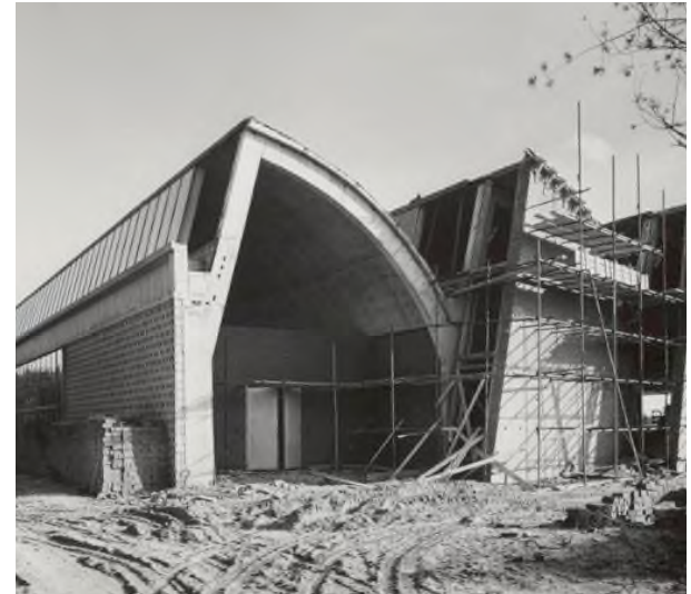
De constructie van Rietvelds verspringing.
