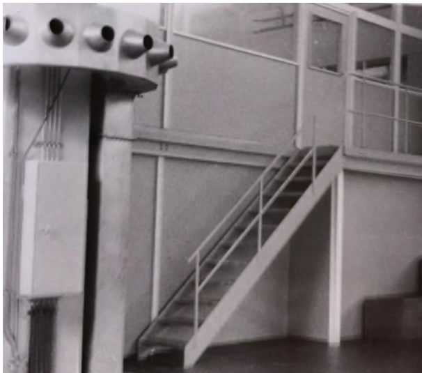
Op de kolommen waren aluminium 'mondjes' aangebracht voor het ventilatiesysteem.
