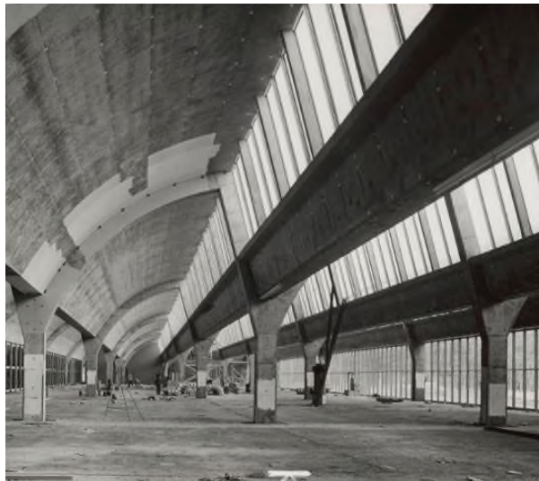
De lichtstroken in het sheddak op het noorden zorgen voor gelijkmatige lichtinval.
