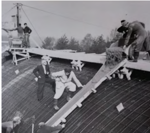
De wapening en het gieten van het beton op het dak.
