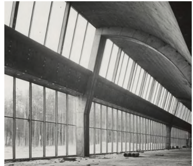
Rietveld bedacht een doorlopende glazen wand aan de noordzijde.
