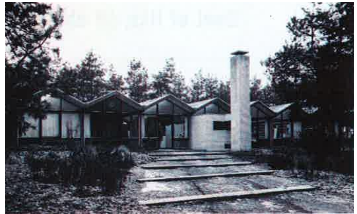
Voorgevel vormgevingsgebouw Weverij de Ploeg 1967 - 1996
