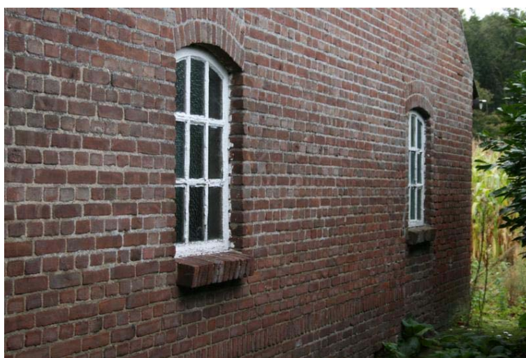
Ramen rechts in de achtergevel
