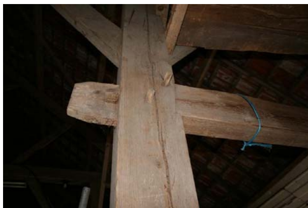
Ankerbalk in de gebintstijl
