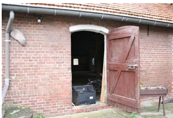
Loopdeur in de rechterzijgevel
