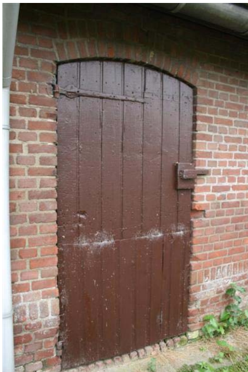
Loopdeur in de linkerzijgevel
