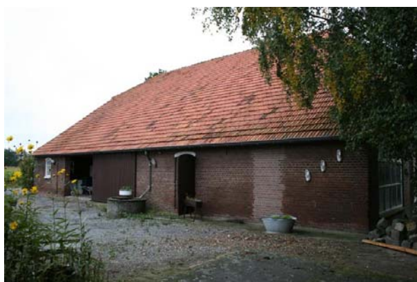
Rechterzijgevel vanaf de achterzijde
