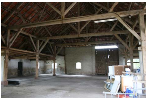
Interieur van de schuur richting de achtergevel
