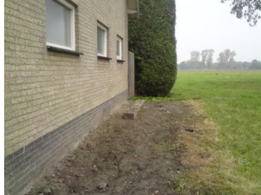
Onbegroeide strook ten oosten van de woning met puindeeltjes aan de oppervlakte. Ook 2 asbestverdachte stukjes plaatmateriaal aangetroffen.
