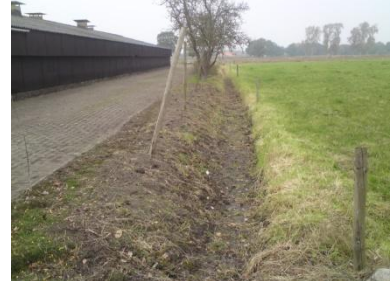
Ondiepe sloot naast de erfverharding op de oostelijke perceelsgrens.
