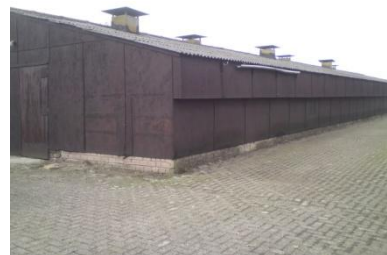
De te vervangen schuur met ten zuiden en oosten ervan het met klinkers verharde erf.
