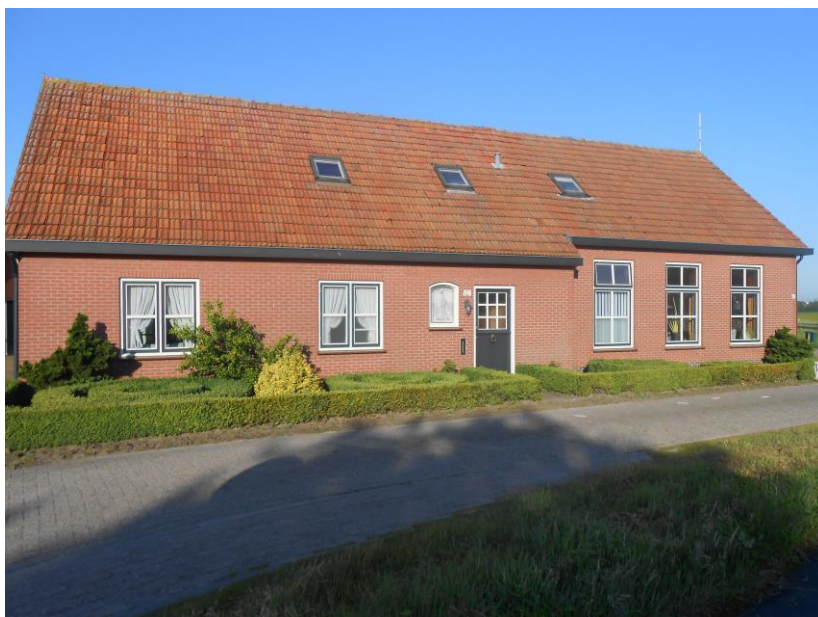
Figuur 7: Foto voor gevel langgevelboerderij
