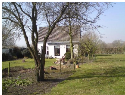
Oostzijde van de woning met de achtertuin, waar een gedeelte van de uitbreiding is gepland.
