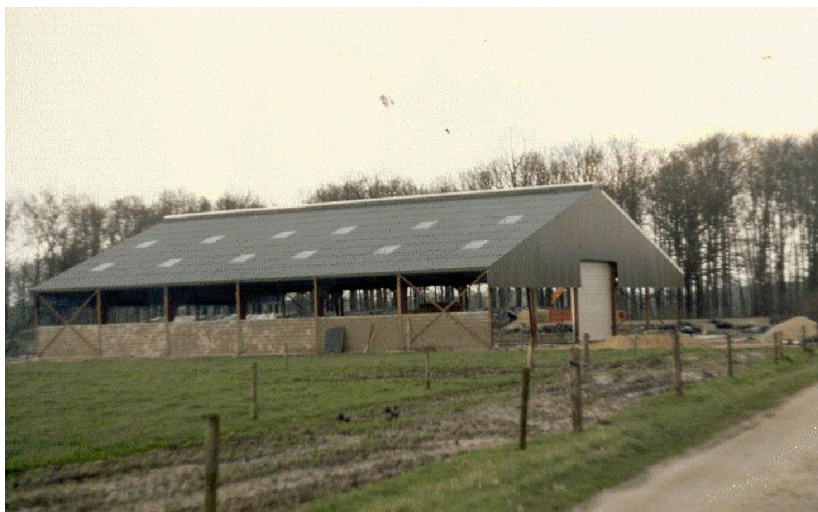
Figuur 10: foto van te slopen bebouwing
