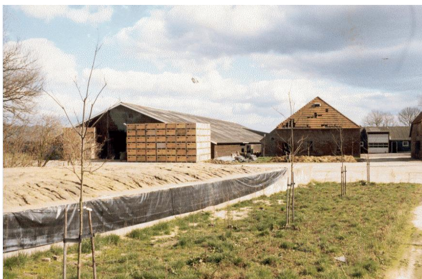
Figuur 12: foto van te slopen bebouwing
