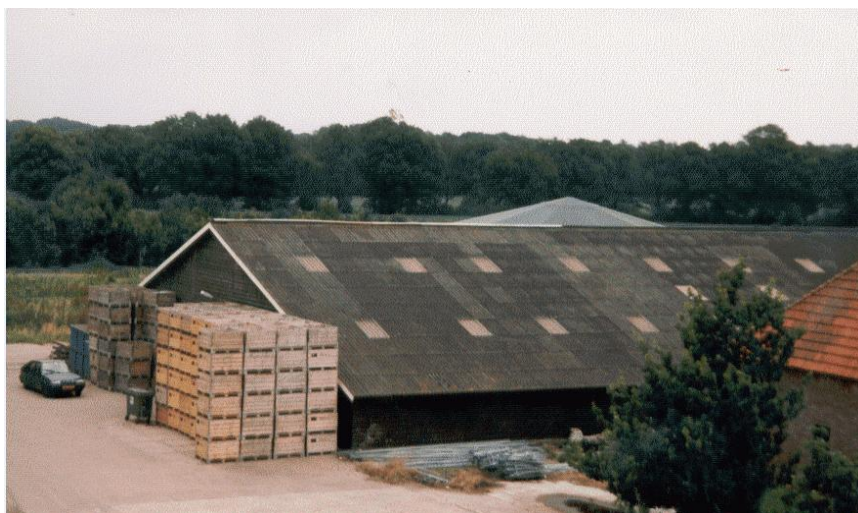
Figuur 11: foto van te slopen bebouwing
