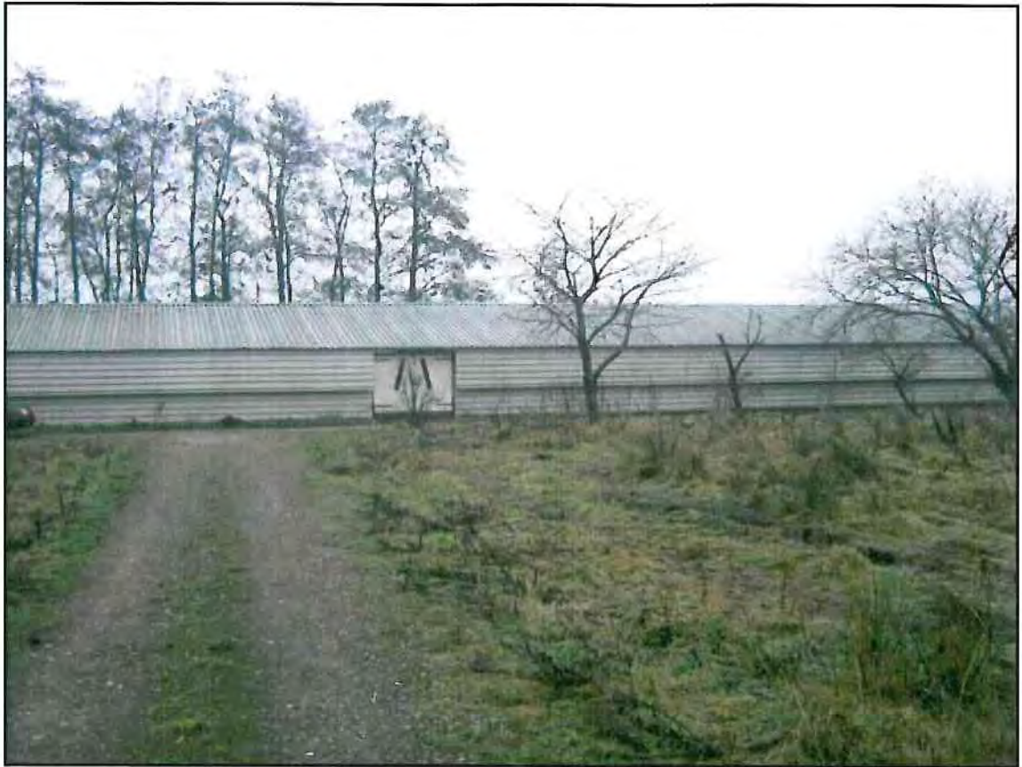
Foto 3: Gezicht over de voormalige kippenshuur. Foto genomen vanaf het toegangspad. De kijkrichting is zuidelijk.
