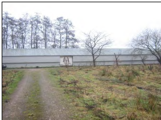
Halfverhard toegangspad naar vml. kippenstal
