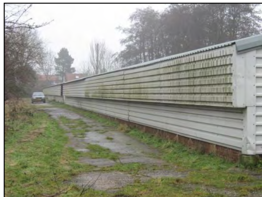
Verhard betonpad langs noordgevel
