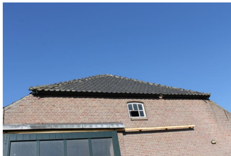
Oorspronkelijk venster onder het wolfseind
