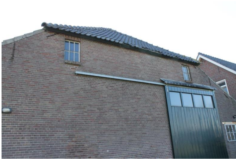
Oorspronkelijke stalen vensters onder het wolfseind
