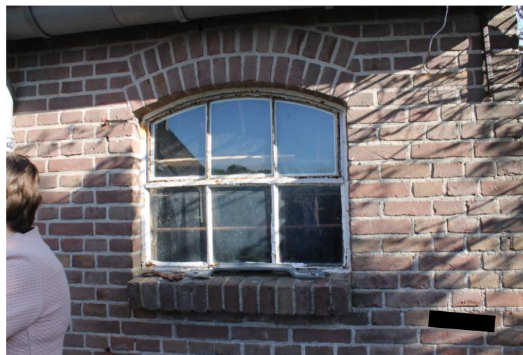
Oorspronkelijk getoogd stalen venster in rechterzijgevel
