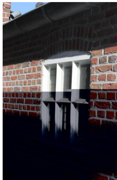
Vernieuwd betonvenster en vernieuwde deur in gewijzigd metselwerk
