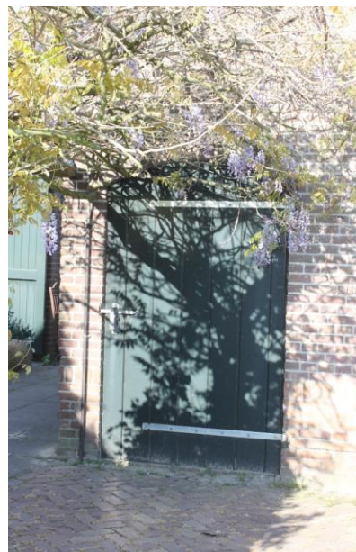
Vernieuwde deuren achtergevel
