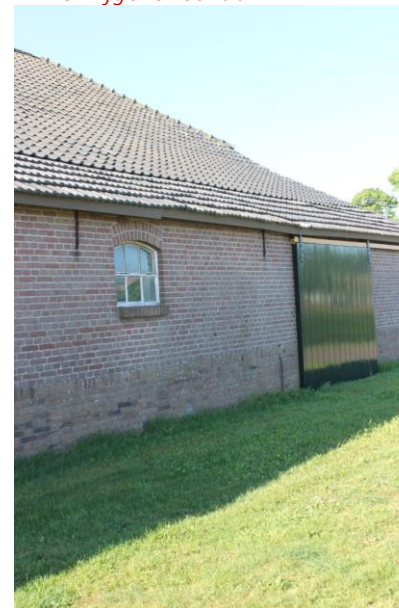
Oorspronkelijke stalen venster met vernieuwde schuifdeur
