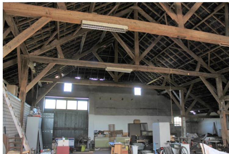
Gebintconstructie schuur richting de voorgevel
