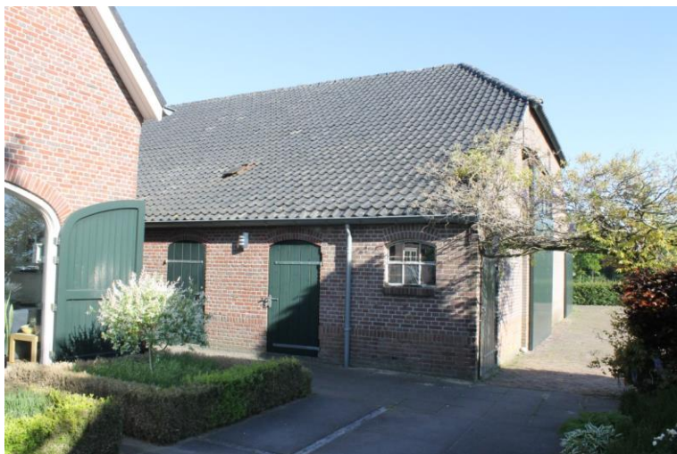
Achterste gedeelte linkerzijgevel
