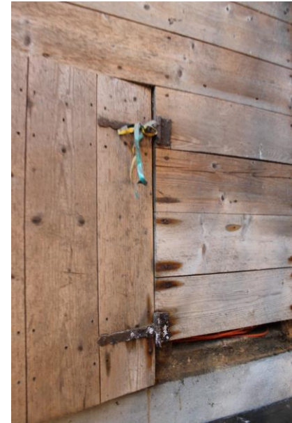
Scharnieren uit de bouwperiode
