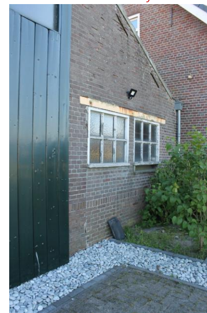
Later aangebrachte betonvensters met dichtgemetselde borstwering
