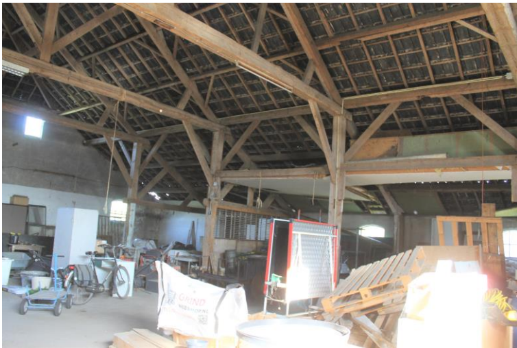
Gebintstijlen met later aangebrachte ruimten (stallen en opslag) in de linkerzijbeuk
