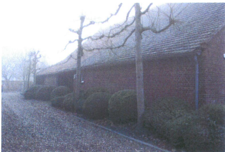
Linkerzijgevel vanaf de straatzijde
