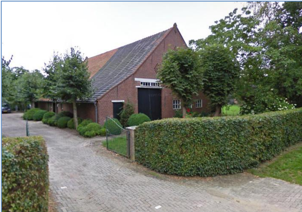
aanzicht langsdeelschuur vanaf Galderseweg
