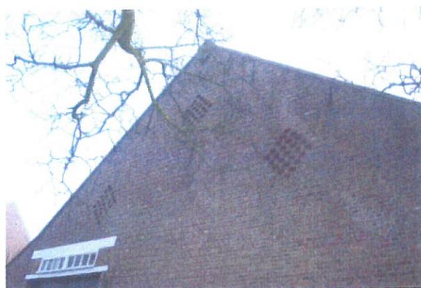
Top met ruitvormige vlakken met openingen
