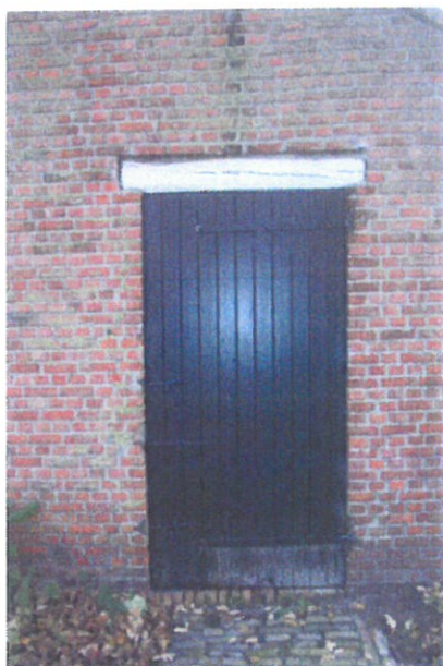
Loopdeur onder houten latei
