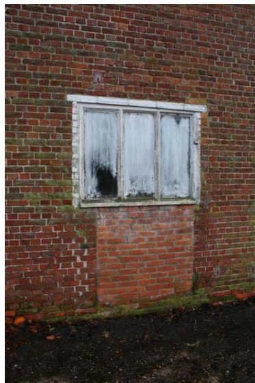
Stalraam in plaats van een deur
