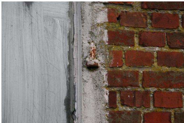
Duim van een loopdeur in het metselwerk naast het raam
