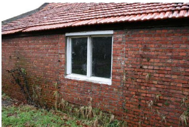
Gewijzigd muurvlak met niet-oorspronkelijk raam
