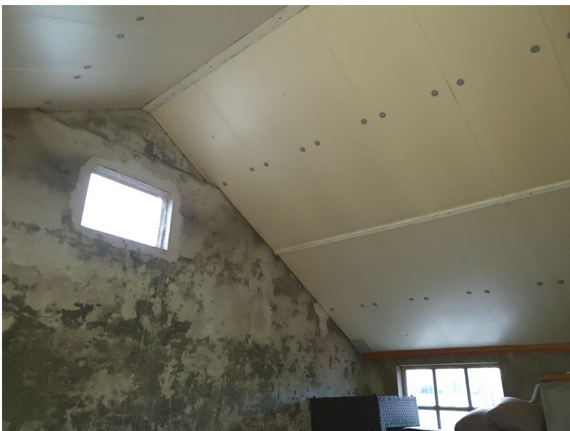
Foto 12. Binnenzijde van de garage
