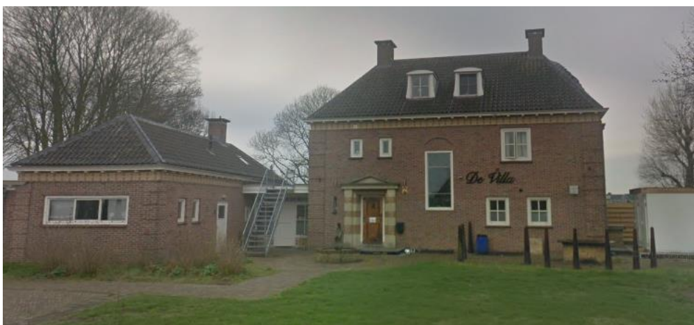
Afbeelding 3: Bestaand hoofdgebouw Schellestraat 2
