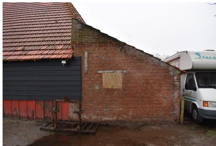
Rechterzijgevel van aanbouw tegen achtergevel.
