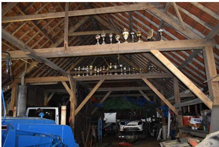
Dekbalkgebinten in de schuur.
