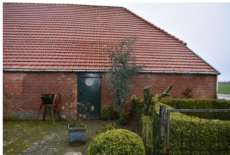
Rechterzijde van de linkerzijgevel.
