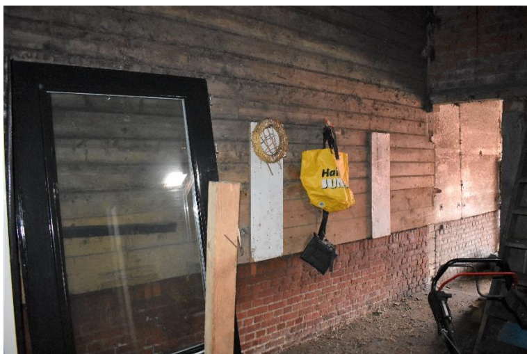
Achtergevel aan binnenzijde aanbouw.
