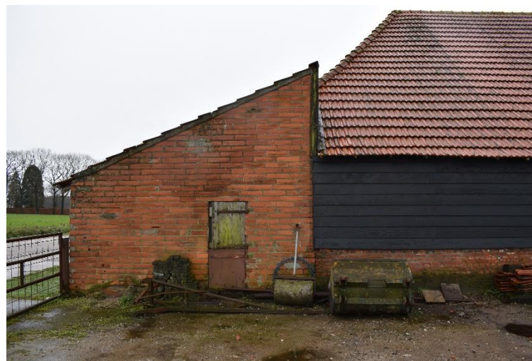
Rechterzijgevel van aanbouw tegen voorgevel.
