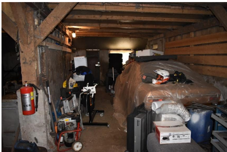
Ruimte met kalkzandstenen tussenmuren.
