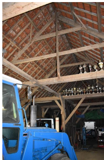
A-spant op dekbalkgebit.
