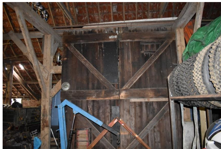
Tussenwand gemaakt van de oorspronkelijke deeldeuren.
