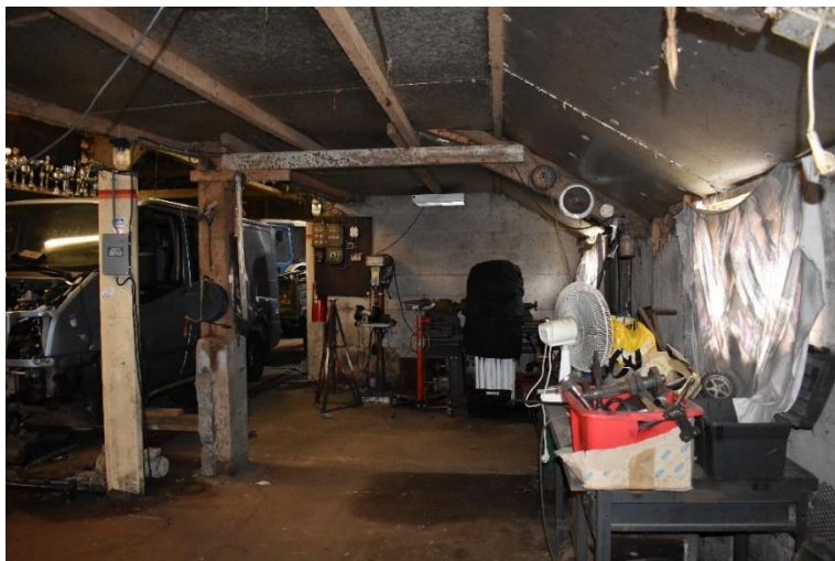
Zicht op een kalkzandstenen tussenmuur.
