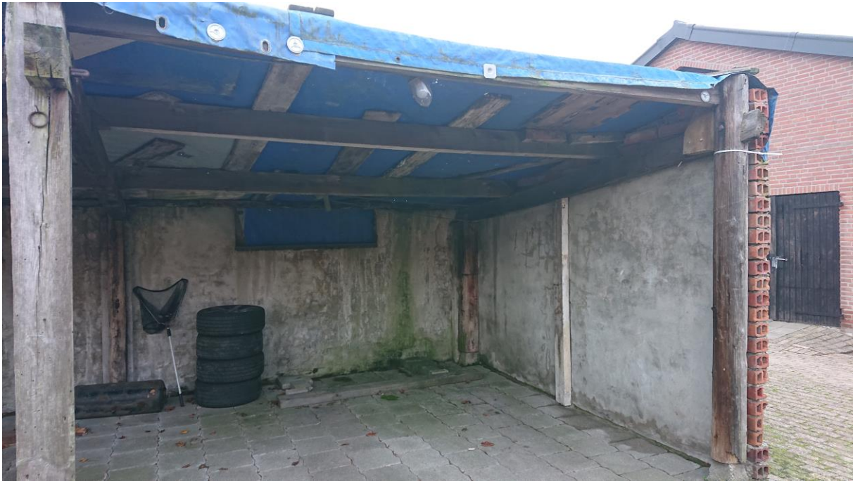
Figuur 20: foto's te slopen bijgebouw bij bedrijfswoning
