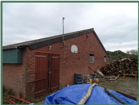
Schuur 2 vanaf het westen
