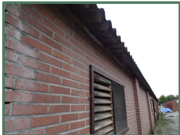
Schuur 1 vanaf het zuiden
