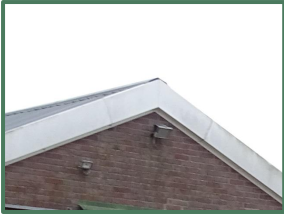
Strak aangesloten boeiboord schuur 3
