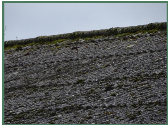
Asbest golfplaten dak schuur 2
