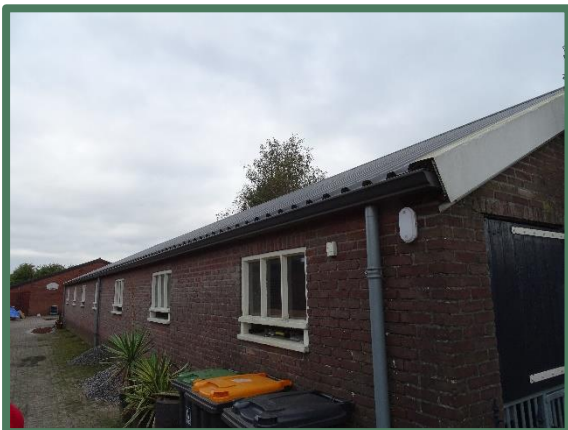
Schuur 3 vanaf het zuiden
