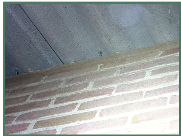
Foto 20: Muurplaat op de aanbouw.
