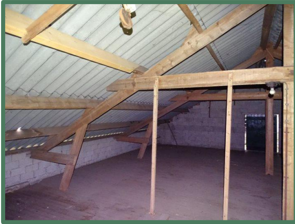
Foto 15: Zolder van de aanbouw.
