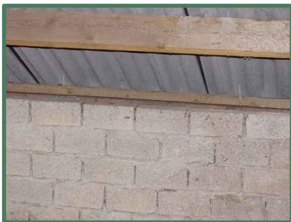
Foto 21: Binnenzijde dak van de aanbouw.
