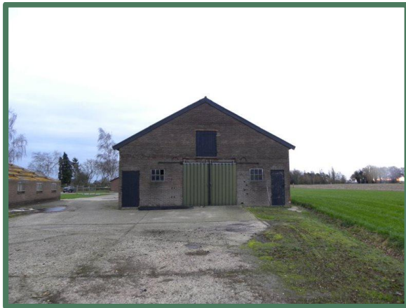
Foto 11: Aanbouw op woonboerderij, vanaf het westen.
