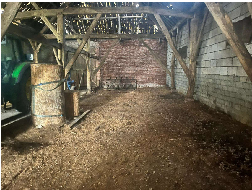
Interieur van de Vlaamse schuur richting achtergevel (west). De foto is genomen in de tasruimte. Opvallend is de zeer lage aansluiting van de korbelen (schuin geplaatste balken) op de gebintstaanders. Mogelijk heeft de achtergevel ook historische waarde. Foto initiatiefnemer, 2023
