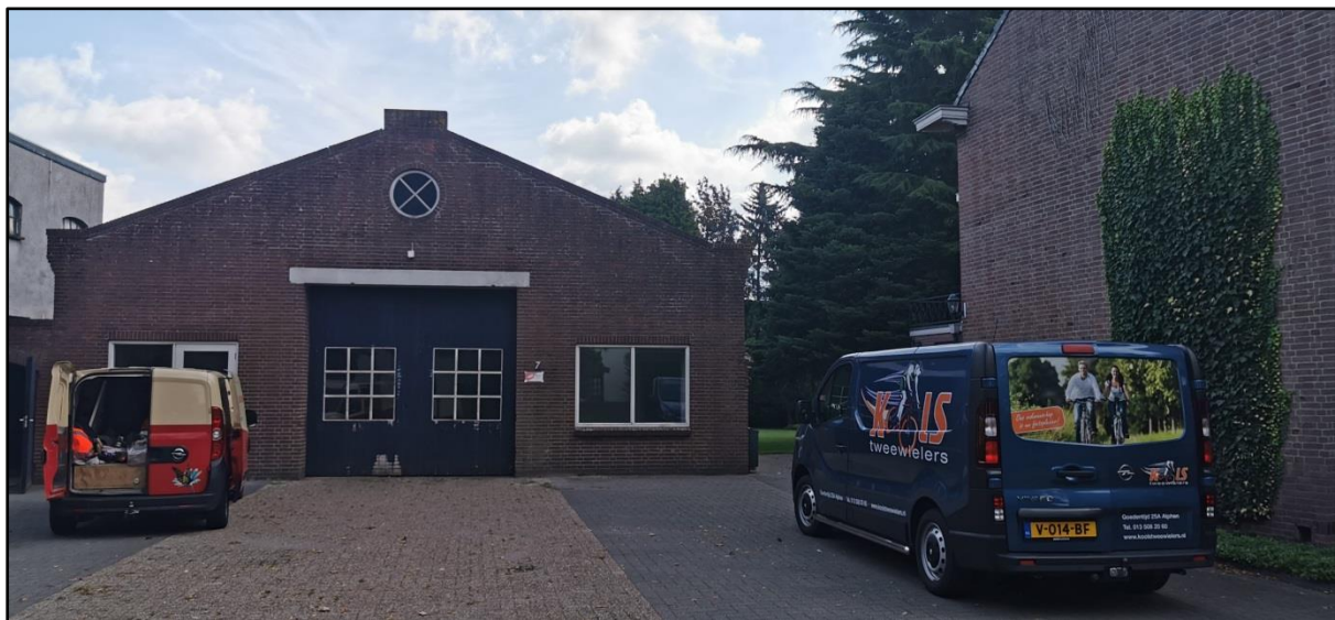
Figuur 19. Het westelijke deel van het onderzoeksgebied, met de loods die vervangen wordt door de nieuwbouw.
