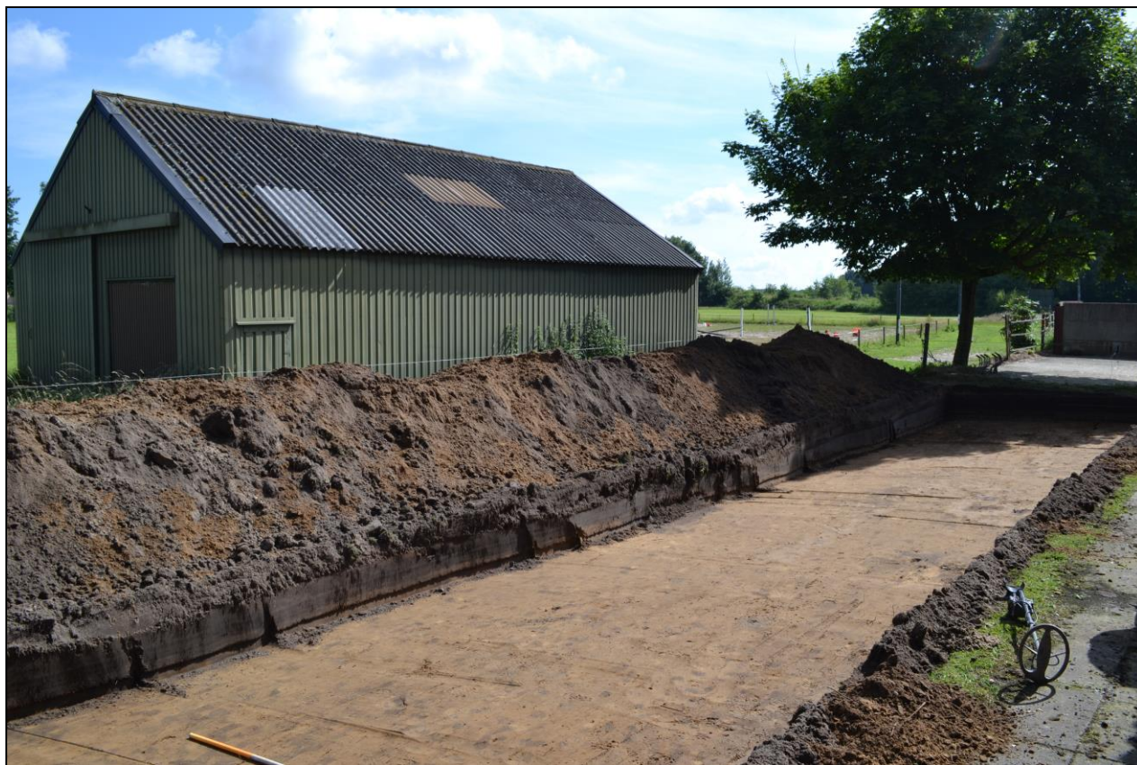
Figuur 2: Het plangebied na aanleg van werkput 1 in noordoostelijke richting.
