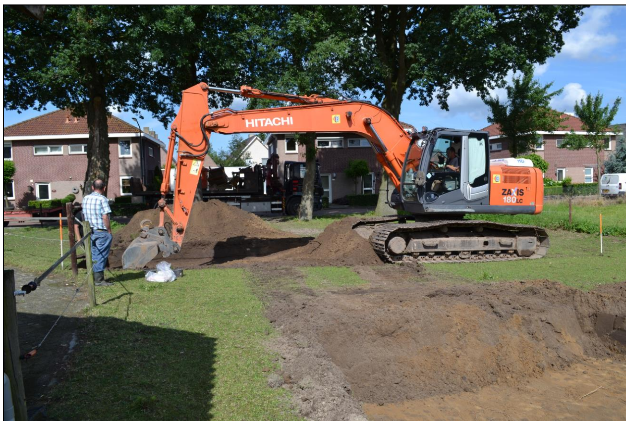
Figuur 3: Het plangebied tijdens de aanleg van werkput 2 in westelijke richting.
