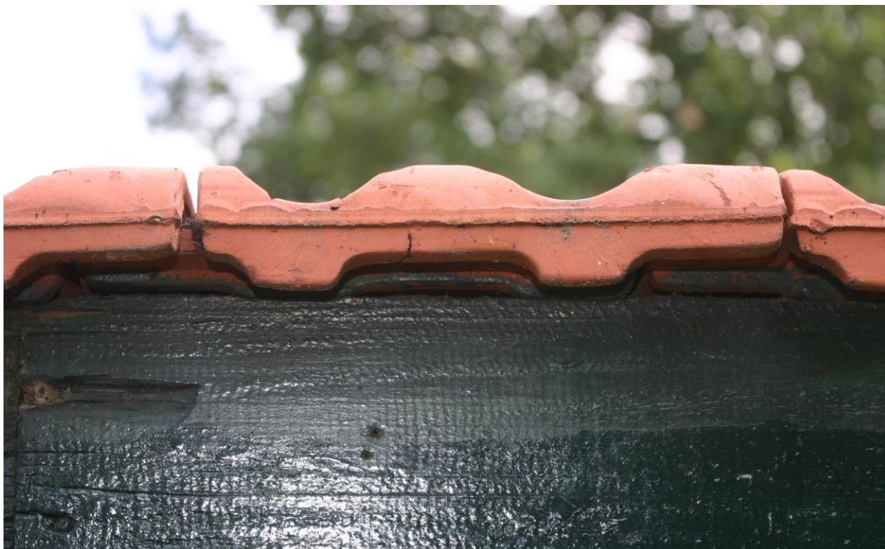
Figuur 4.5.1. Onder de onderste rij dakpannen is de ruimte veel te nauw ( \pm 2 cm) voor huismussen.
