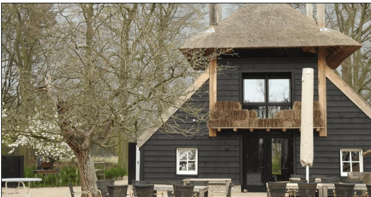
Foto Hooibergschuur Heistraat 18 (de Hooimijt), bron: Landgoed Ulvenhart, 2020.
