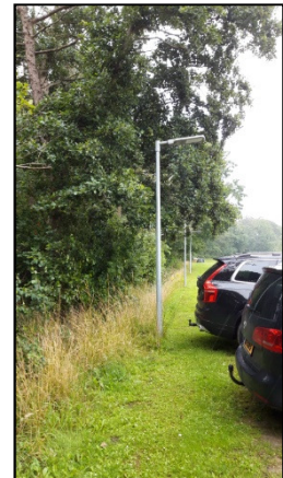
Figuur 17. Lantaarnpaal op het parkeerterrein ten westen van het NNB.
