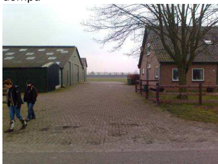
Te slopen schuren (links) en te slopen woonhuis (rechts), ongebruikt door huidige bewoners.
