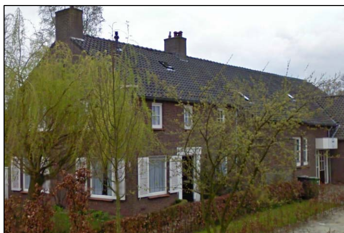
Zijgevel van de woning aan de St. Janstraat 12.
