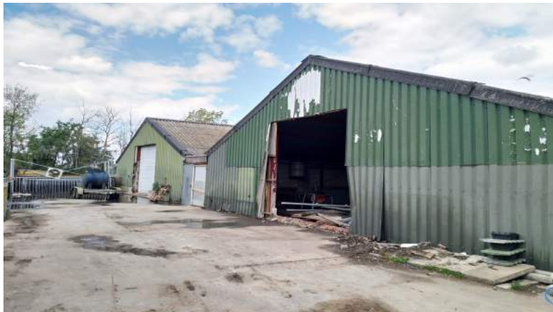
De varkensstal die t.z.t. wordt gerenoveerd. Foto: V. Stuit | Ecoresult B.V.
