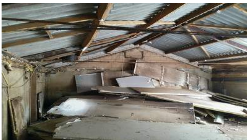
Binnenkant te slopen varkensstal. Dakbeschot is er al uit gesloopt, ligt op de grond. Foto: V. Stuit | Ecoresult B.V.
