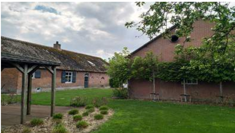
Plangebied vanuit het oosten gezien. Links woonhuis, rechts te slopen varkensstal met twee open ventilatie gaten. Foto: V. Stuit | Ecoresult B.V.
