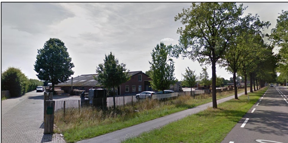
Afbeelding 4: Zichtfoto op plangebied (Bron: Google Maps)
