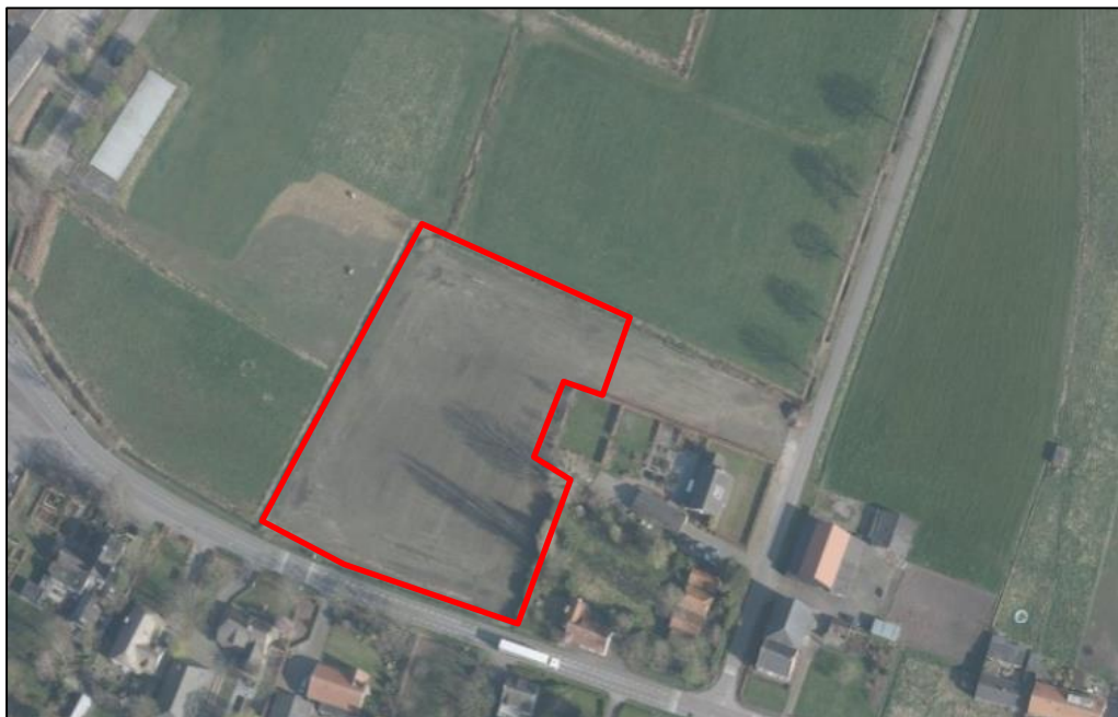
Satellietfoto locatie Alphensebaan (rood omkaderd). Bron: cyclomedia, 2019.
