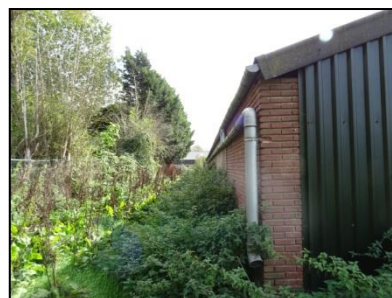
Figuur 5. Laag struikgewas aan westzijde van de schuur.
