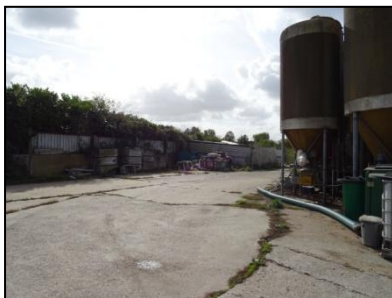
Figuur 9. Verhardingen en silo's .
