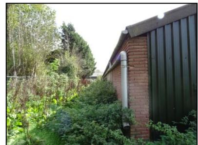
Figuur 11. Laag struikgewas aan westzijde van de schuur.
