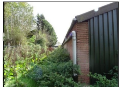
Figuur 5. Laag struikgewas aan west-zijde van de schuur.
