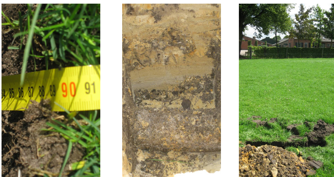
Foto's van het drainagesysteem
