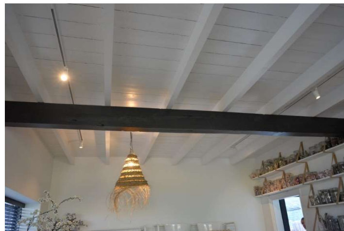
Balkenplafond en houten balk in de voormalige slaapkamers
