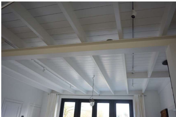
Balkenplafond en stalen balk in de woonkeuken
