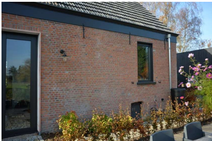
Opkamer- en keldervenster
