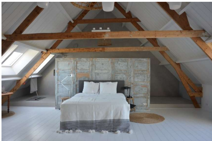
Verdieping woongedeelte met schaarspanten
