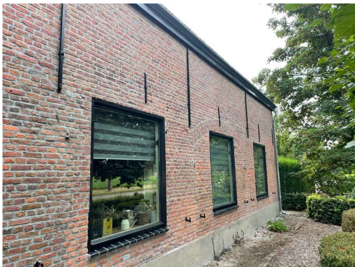
Voormalig bedrijfsgedeelte waar de boog die zich boven de staldeuren bevond nog zichtbaar is; bovenaan dubbele ankers.
