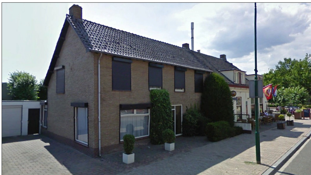
Bedrijfswoning op het adres St. Janstraat 2a. Bron: Google, 2016
