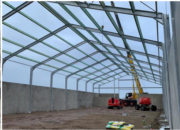
Werkzaamheden op de bouw, plaatsen pallet, plaatsen spanten en monteren prefab stal
