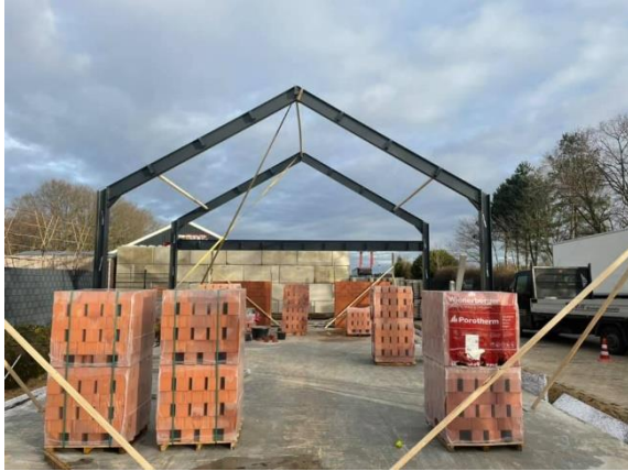
Werkzaamheden op de bouw, plaatsen pallet, plaatsen spanten en monteren prefab stal
